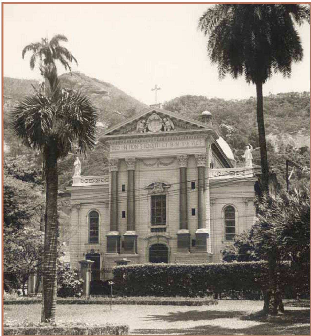
A igreja de Santo Inácio após a reforma da fachada realizada em 1958
