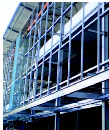
A construção do novo Centro Esportivo do CSI está na fase de instalações hidráulicas, alvenaria e esgoto.
